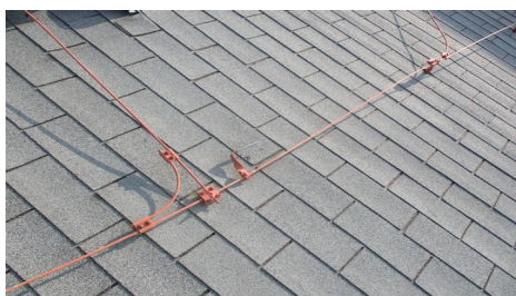
foto /4/ Nedostatečně upevněné hromosvodné vedení
