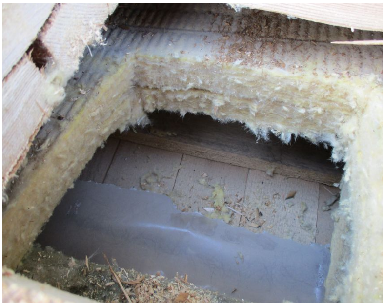
foto 16/ Ukončení parotěsnící folie
